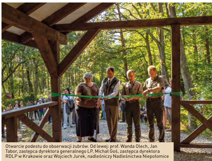
Podest do obserwacji żubrów wybudowano w 2023 r.
